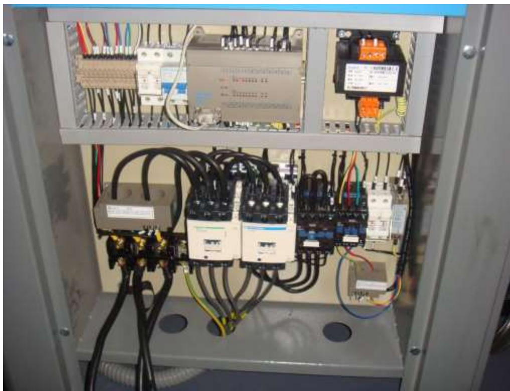
Блок серого цвета- система автоматической проверки системы PLC
